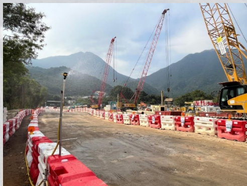
定時於工地進行灑水防止塵土飛揚
