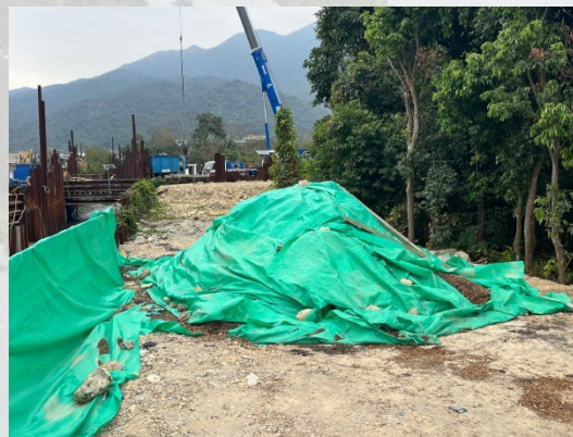
以帆布遮蓋建築物料防止塵土飛揚
