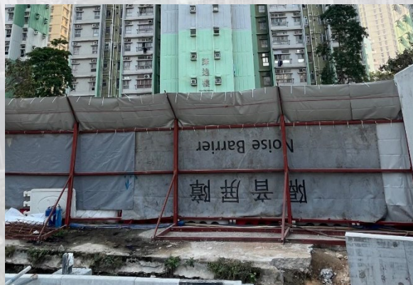
設置隔音屏障
