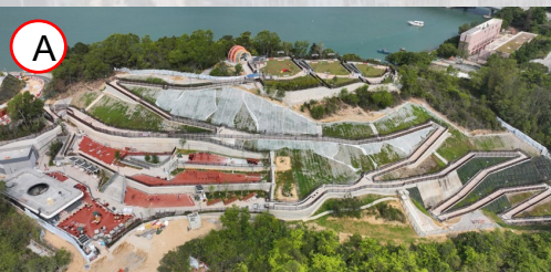
29A區休憩處 進行剩餘的園景工程
