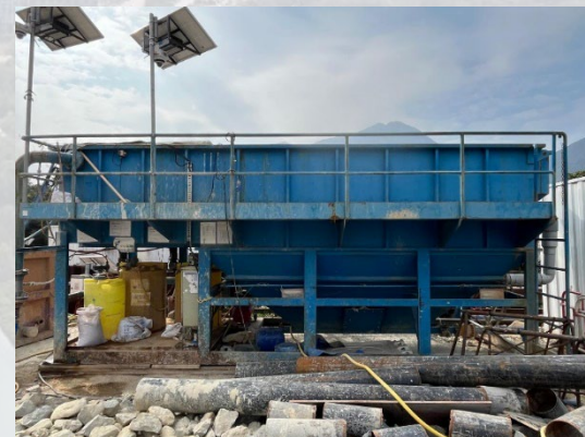
設置污水處理設施
