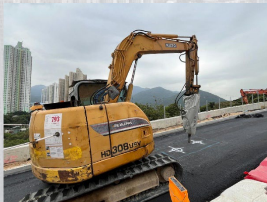
使用隔音布包裹破碎錘
