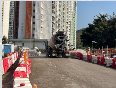
地盤出口設立洗車設施
